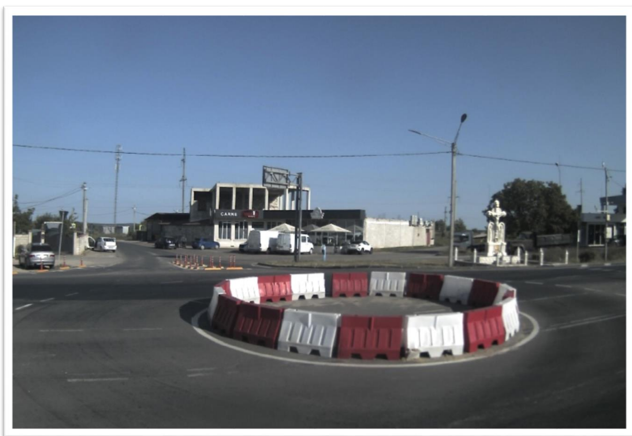
Figura 9. Intersecția drumurilor publice naționale R6 Chișinău – Orhei – Bălți, km 30,550 cu drumul G74 R6 – Peresecina – Donici, după amenajarea cu sensuri giratorii provizorii.
