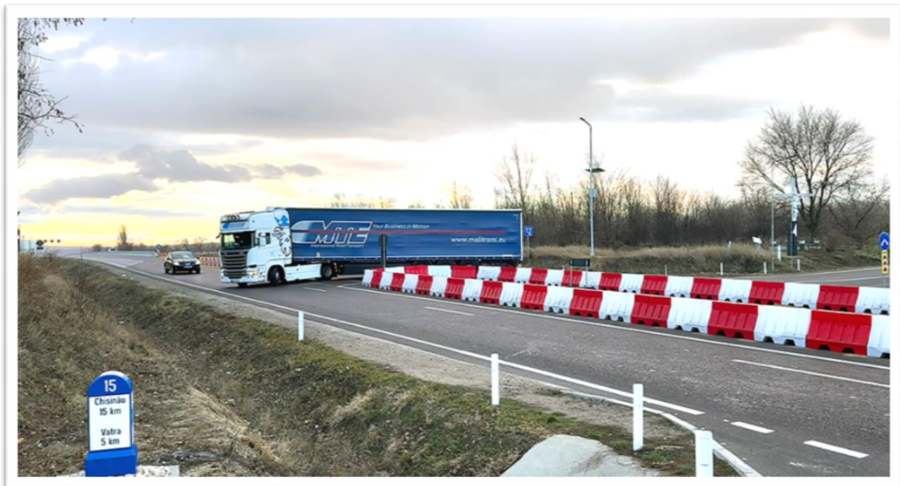
Figura 3. Intersecția drumurilor publice naționale R1 Chișinău – Ungheni – fr. cu România, km 15,000 cu drumul de acces către s. Cojușna, după amenajarea cu sensuri giratorii provizorii.
