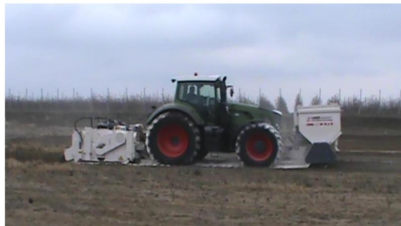
**Figura F.1 Primul pas** - crearea compoziției granulometrice necesară a pămîntului /solului, pregătirea stratului pentru stabilizare, introducerea de materiale foarte fine (făină de calcar sau dolomită, ciment, sau alte componente)
