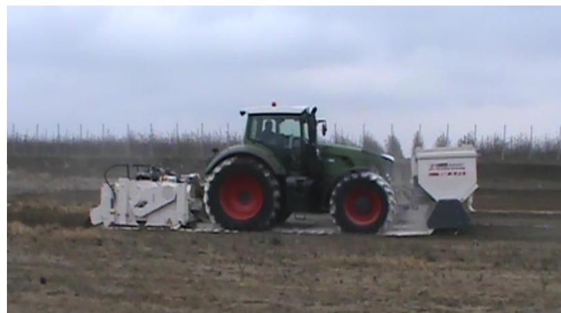
**Рисунок F.1 Первый проход** - создание необходимого гранулометрического состава грунта, подготовка слоя грунта, внесение мелкодисперсных материалов (доломитовой «известняковой» муки; цемента или других компонентов)
