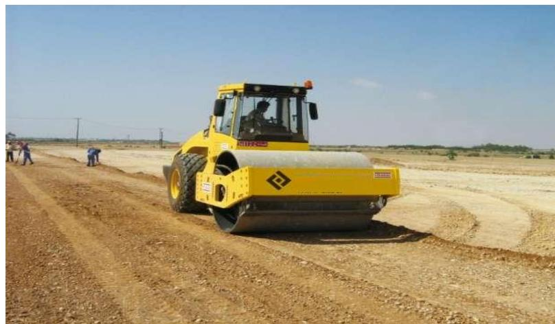
**Рисунок F.3** Предварительное уплотнение обработанного стабилизатором слоя грунта катком с гладким бандажом и с системой мониторинга и автоматической регулировкой уплотнения
