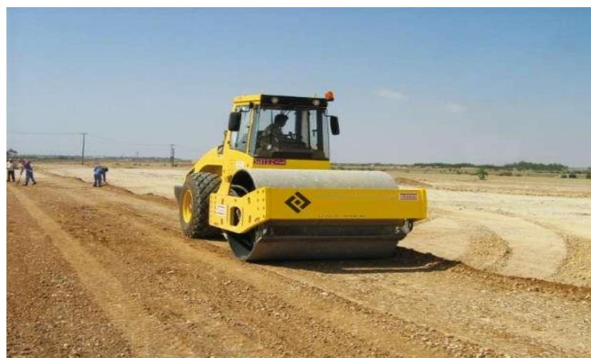
**Figura F.5 Pasul 5 - compactarea definitivă a străzii consolidată cu rulou cilindru compactor vibrator dotat cu sistem de monitorizare și reglare automată a procesului de compactare**
