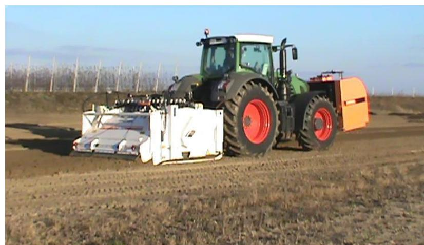
**Figura F.2 Pasul 2** – stabilizarea stratului de pămînt prin pulverizarea amestecului stabilizant (apă+stabilizator sau componente similare) și malaxarea cu pămîntul pe parcursul frezării (mărunțirii) pămîntului.
