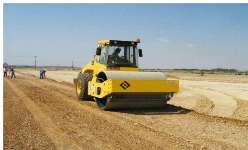
**Рисунок F.5** Окончательное уплотнение обработанного стабилизатором слоя грунта катком с гладким бандажом и с системой мониторинга и автоматической регулировкой уплотнения
