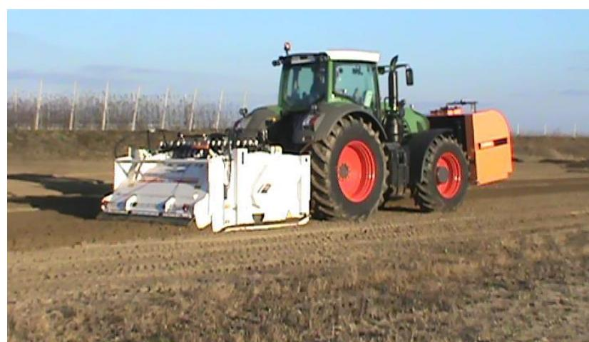
**Рисунок F.2 Второй проход** – создание слоя грунта, внесение мелкодисперсных смесей вода + стабилизатор или подобных компонентов в процесс фрезерования (измельчения) грунта
