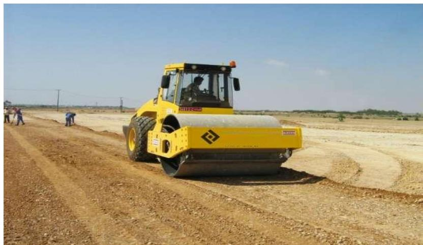
**Figura F.3 Pasul 3 - precompactarea stratului din pămînt tratat cu rulou cilindru compactor vibrator dotat cu sistem de monitorizare și reglare automată a procesului de compactare**
