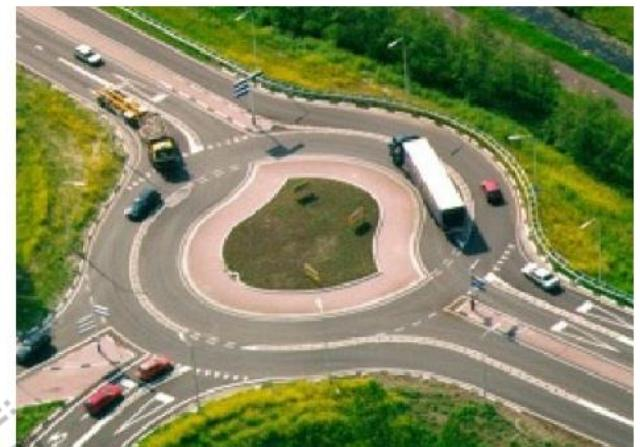
**Рис. 7 Примеры обустройства пересечений по типу "турбо-кольца"**
