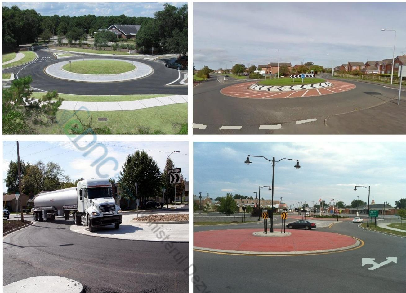
**Рис. 8 Примеры обустройства пересечений по типу "мини-кольцевых "**
